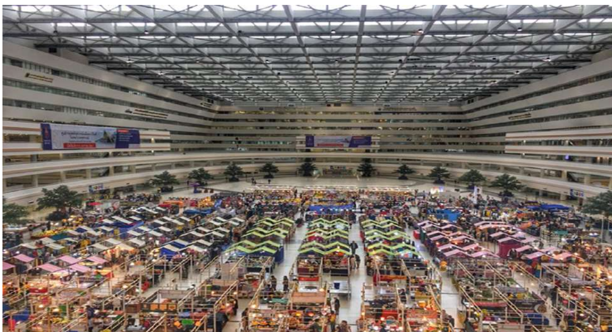
ภาพที่ 5 พื้นที่ชั้น 2 อาคารรัฐประศาสนภักดี (อาคาร B) ลานอเนกประสงค์
