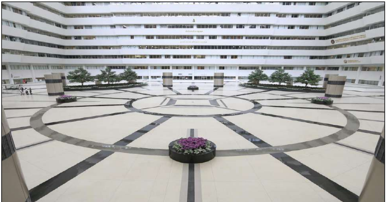
ภาพที่ 3 พื้นที่ชั้น 2 อาคารราชบุรีดิเรกฤทธิ์ (อาคาร A)
